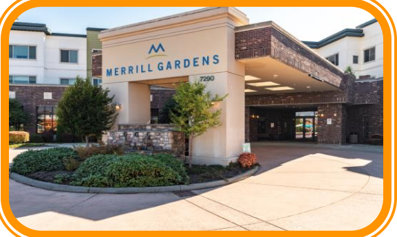
メリル・ガーデンズ高齢者住宅施設 Merrill Gardens Senior Living Facility
